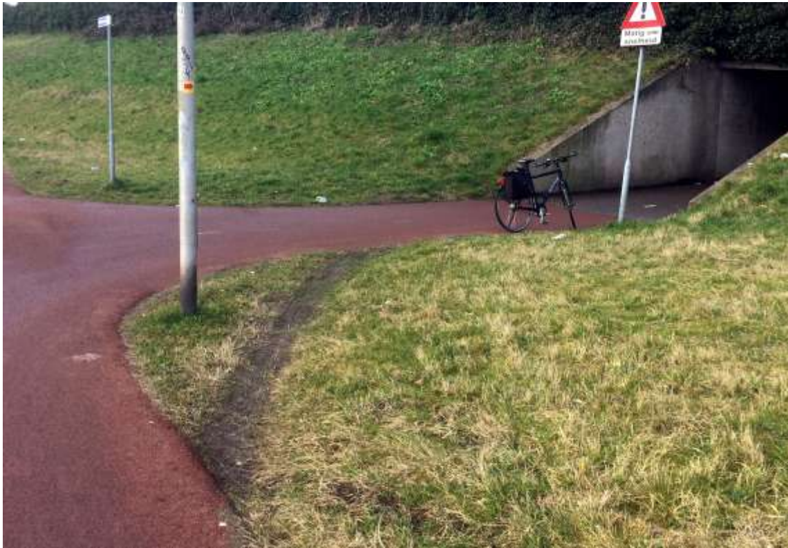
Olifantenpaadje bij de Algeratunnel
