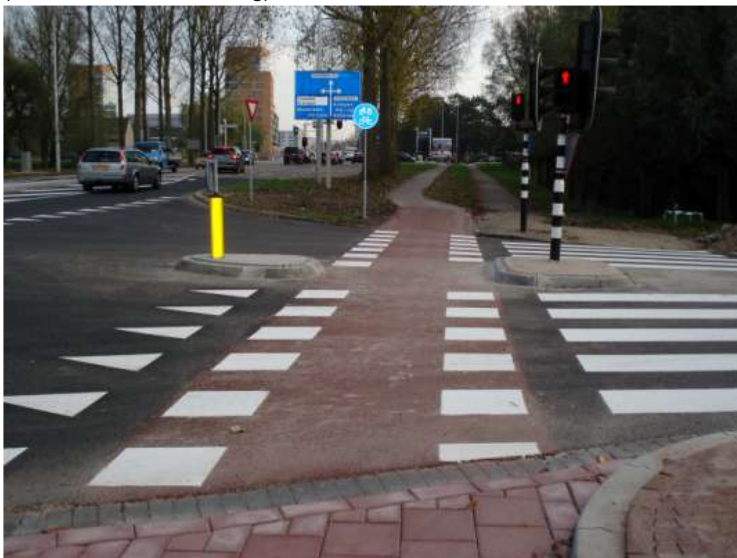
Foto: Fietsoversteek Kanaalweg met 's-Gravenweg
