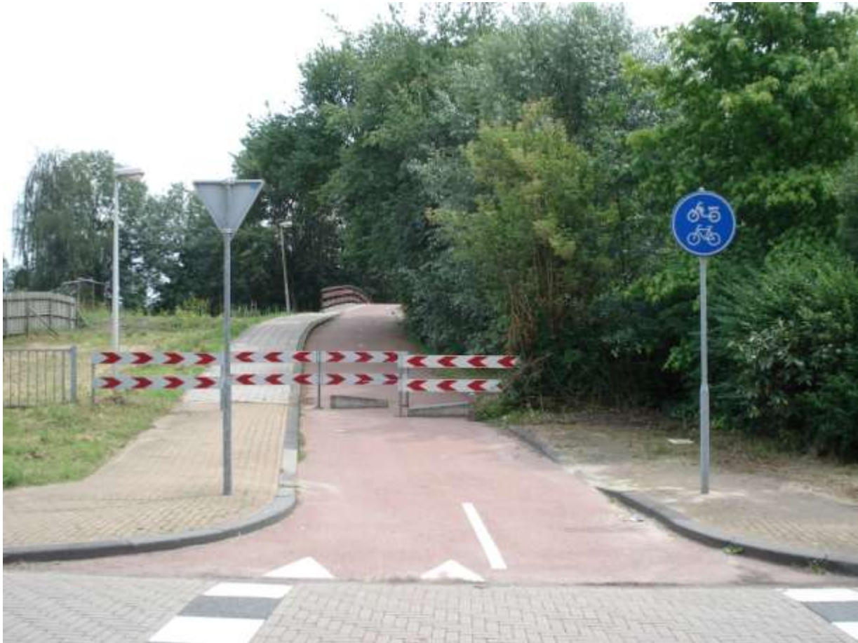
Foto: Een van de fietssluisen aan de Bermweg, achter IJsselcollege Kanaalweg
