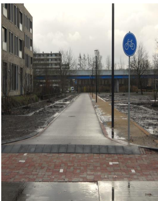
Fietspad door het Amandelpark.
