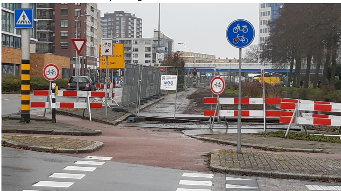
Werkzaamheden op de Rivierweg met veel omleiding voor fietsers.
