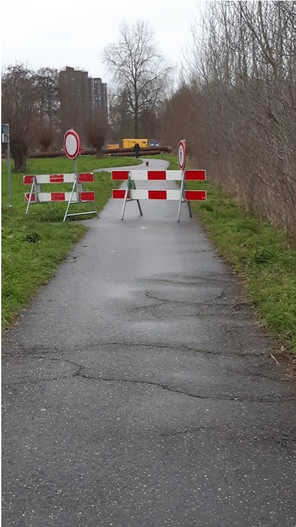
Werkzaamheden op de Klaas Klinkertkade
