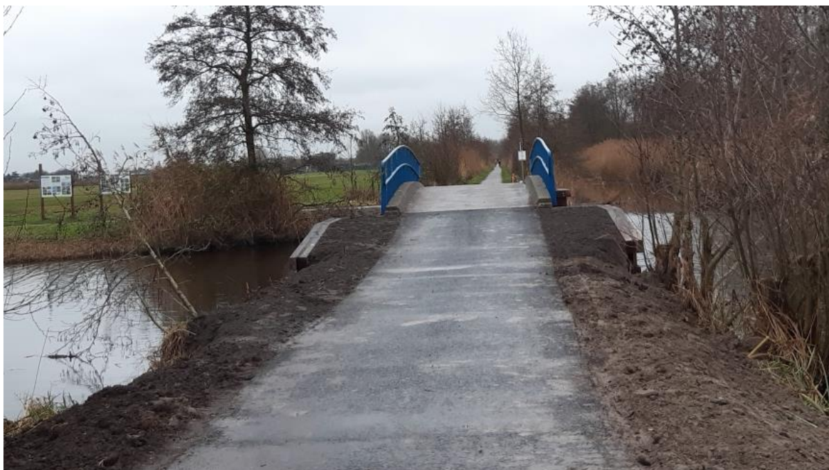
Verbreding van de oevers en versterking van de op- en afritten op de Ouderkerkselaan.
